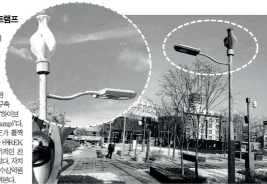
◇충전시청 및 광장에 설치된 하이브리드 스트리트램프.
