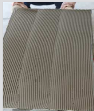
④ 타일 뒷면에 접착제 도포 - 톱니훅손을 사용하여 타일 뒷면에 전면 도포한다.(한 방향으로 도포)
