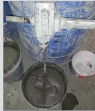
② 접착제 혼합 - 접착제 설명서 확인 후 배합한다.
