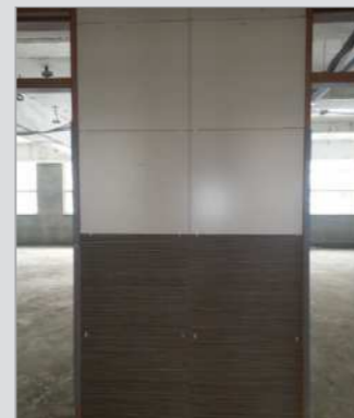
⑥ 타일부착 완료 후 - 줄눈제를 이용하여 줄눈을 넣어준다 - 깨끗히 청소한다.
