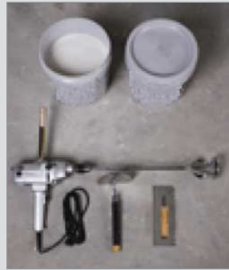
① 접착제 및 시공도구 준비 - 바탕면의 청소 (건조할 경우 물을 적셔준다.) - 바탕면은 평활해야 한다.
