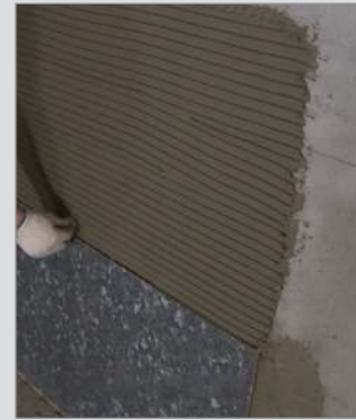
③ 바탕면에 접착제 도포 - 톱니훅손을 사용하여 바탕면에 전면 도포한다.(한 방향으로 도포)
